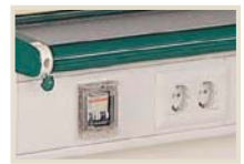
水平线槽的安装
