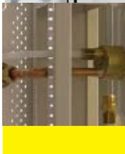
固定服务装置管道连接头安装在风柜内层隔离域内, 可提供一个更大可用工作面积。
