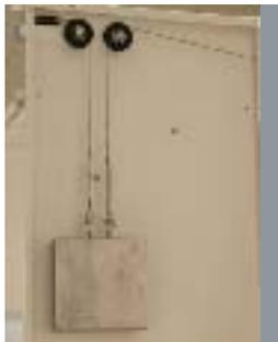
单个安全玻璃配重块配备了自动固定的逆重块, 在缆绳破损情形下, 可不费力控制安全玻璃的位置。
