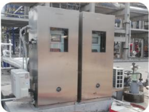
安徽中石化现场
