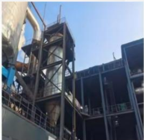
高炉炉顶均压放散收集装置
