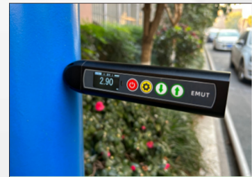
室外 管道测厚
