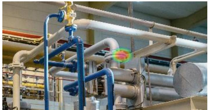
Si2-LD是一款简单易用的声学成像仪，可用于定位和量化压缩气体泄漏，检测机械轴承故障。借助Si2-LD这款轻便智能的单手式声学成像仪开展日常维护工作，可以帮助用户提高检修效率，节省安装和运维费用的支出。
