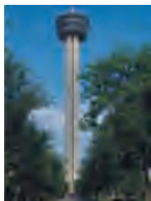
高塔的安装、监测
