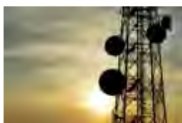
通讯基站天线调整
