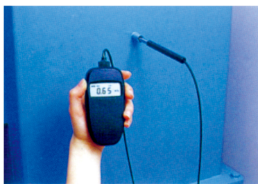
管道内的风量测试
