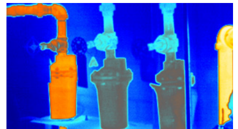
暖通空调检修
