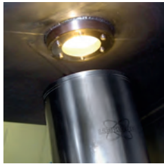
非接触式探头安装在设备视窗前
