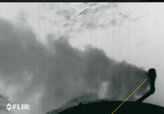
储罐上的通气 泄压阀
