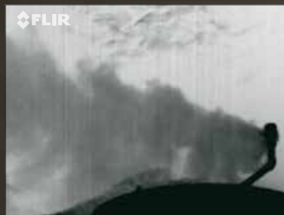
储油罐上的通气泄压阀
