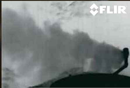
储存罐泄压阀放散
