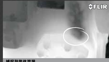
捕捉到气体泄漏
