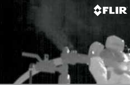
常见的SF 6 管道泄漏
