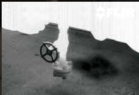
天然气生产现场的甲烷泄漏
