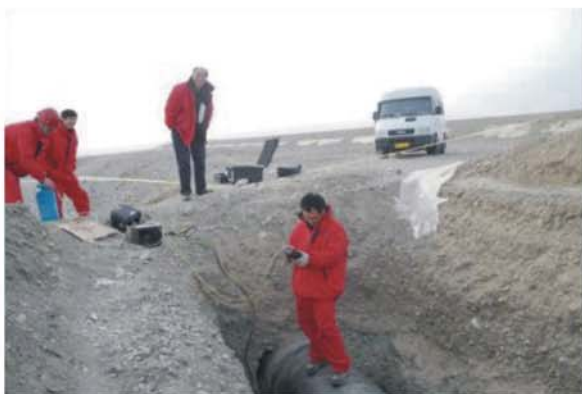
石油管线自动腐蚀检测
