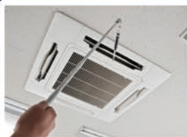
空调出风口测试
