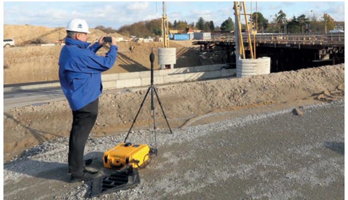
图1: 施工现场使用的便携式NMT
