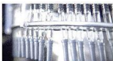
无菌制药洁净生产区/检验区
