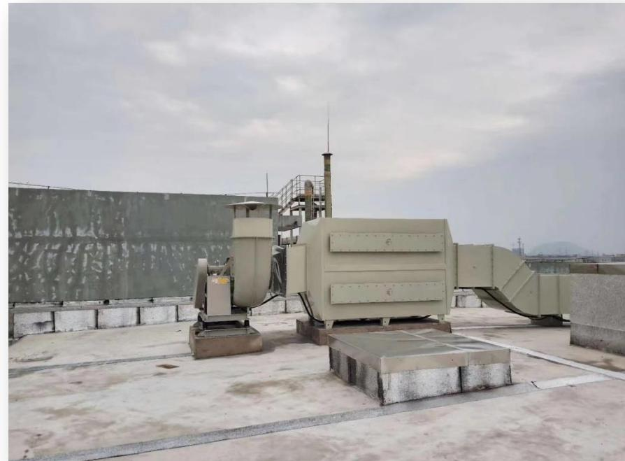
活性炭吸附过滤箱是一种废气净化、吸附异味的环保设备产品，采用优质吸附活性碳作为吸附媒介，有机废气通过多层吸附层进行过滤吸附，从而达到净化废气的目的。活性炭吸附塔现广泛用于 电子原件生产、电池（电瓶）生产、酸洗作业、实验室排风、冶金、化工、医药、涂装、食品、酿造等废气处理。
