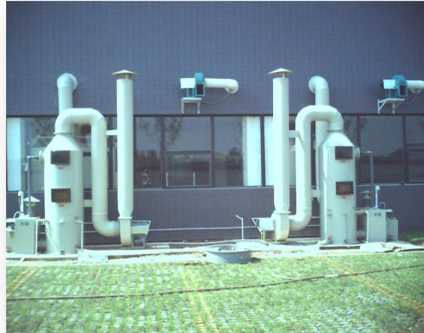
实验室无机废气处理装置 PP、PVC 为主要材料生产的塔设备均为填料喷淋塔。填料采用 PP 材质的鲍尔环或空心球。根据气体吸收过程中气液两相在表面上进行传质反应以及传递速率和比表面积成正比的原理，因此采用填料来增大两相接触的比表面积，使两相充分接触，从而达到吸收或净化废气的目的。
