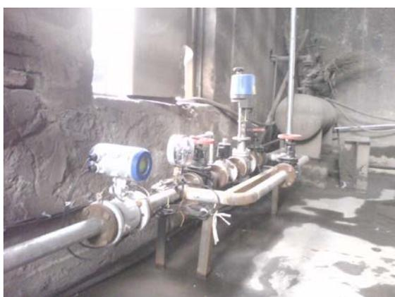
图 3 MMC-21 水分测量控制系统
