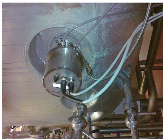
双层罐体安装
