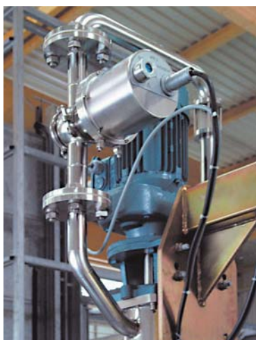
泵强制循环管道安装
