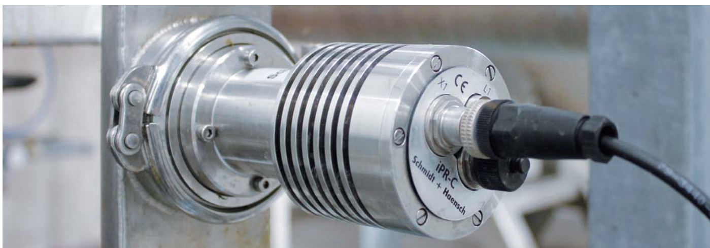
直管道变径安装
