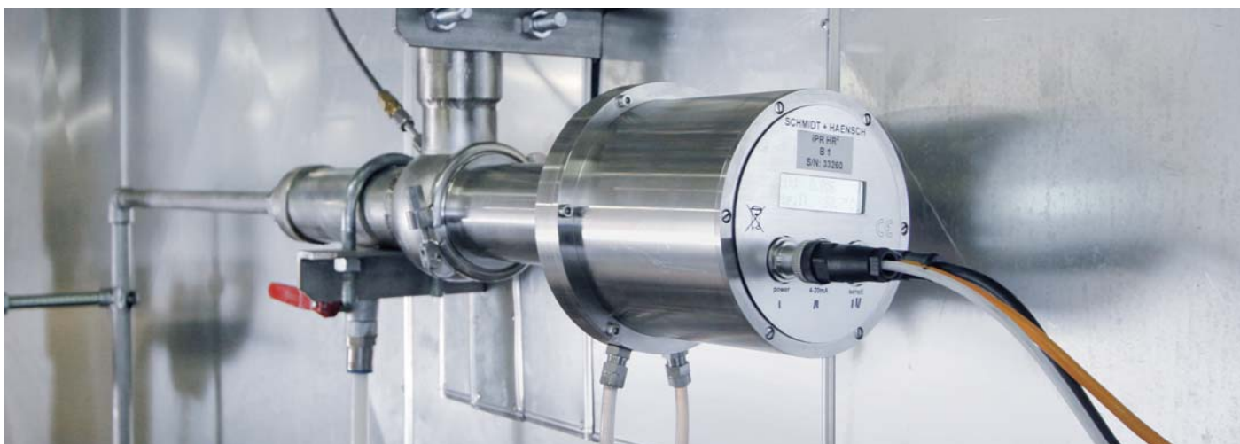
采用90度管道适配器安装在弯角处，并带有高压清洗装置
