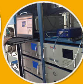
地面监测站房集成 在线连续监测式
