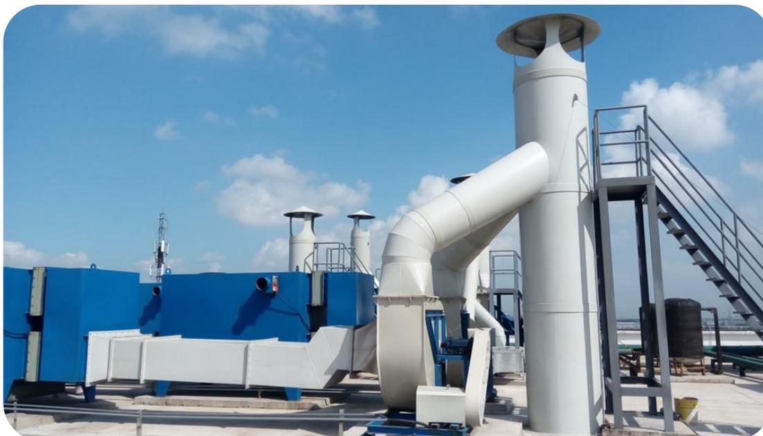
PP 离心机通风机系列,是目前最理想的耐腐通风设备,产品具有强度高、耐腐性强、运转平稳、噪声低等优良性能,经过不断改进、精心设计,产品日益完善已广泛替代其它耐腐材料的风机。
