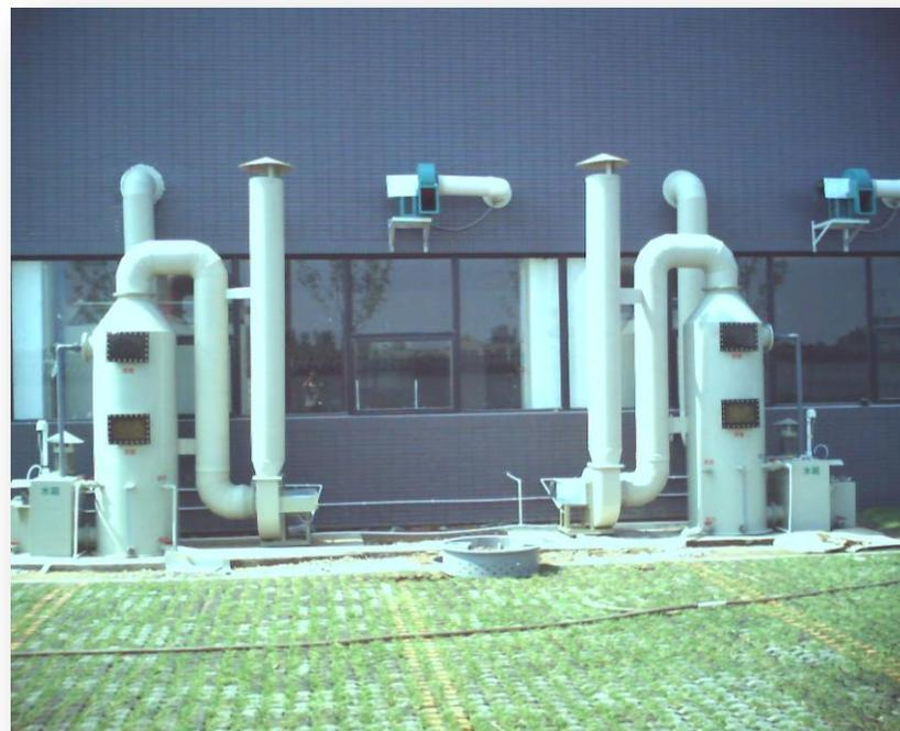
实验室废气处理装置 PP、PVC 为主要材料生产的塔设备均为填料喷淋塔。填料采用 PP 材质的鲍尔环或空心球。根据气体吸收过程中气液两相在表面上进行传质反应以及传递速率和比表面积成正比的原理，因此采用填料来增大两相接触的比表面积，使两相充分接触，从而达到吸收或净化废气的目的。
