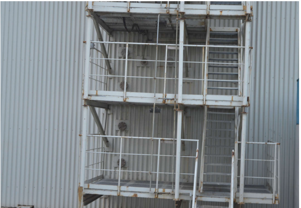
图 14—6 烟气排放监测点位监测设施监测孔设置规范的示例
