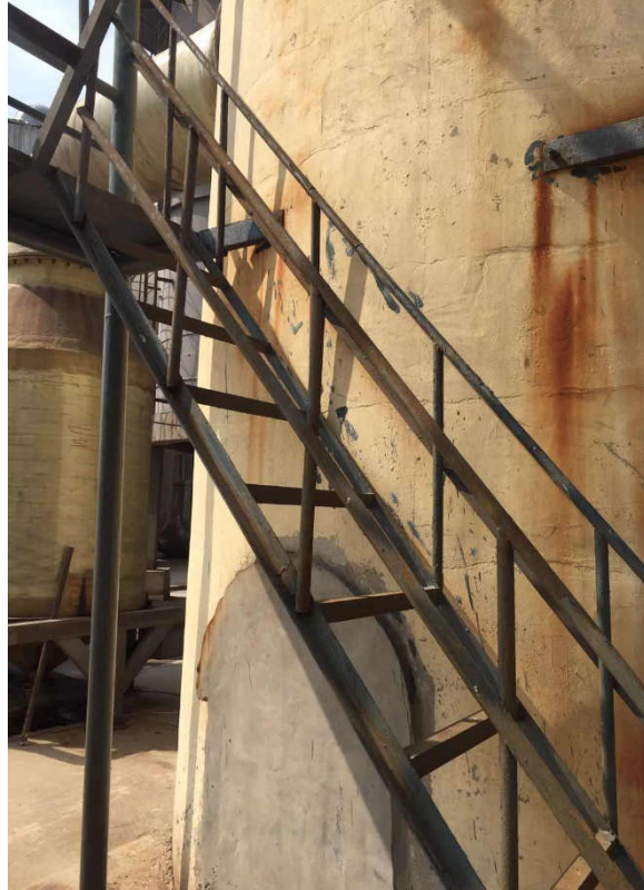
图 14—7 烟气排放监测点位监测设施步行梯和护栏不合格的示例
