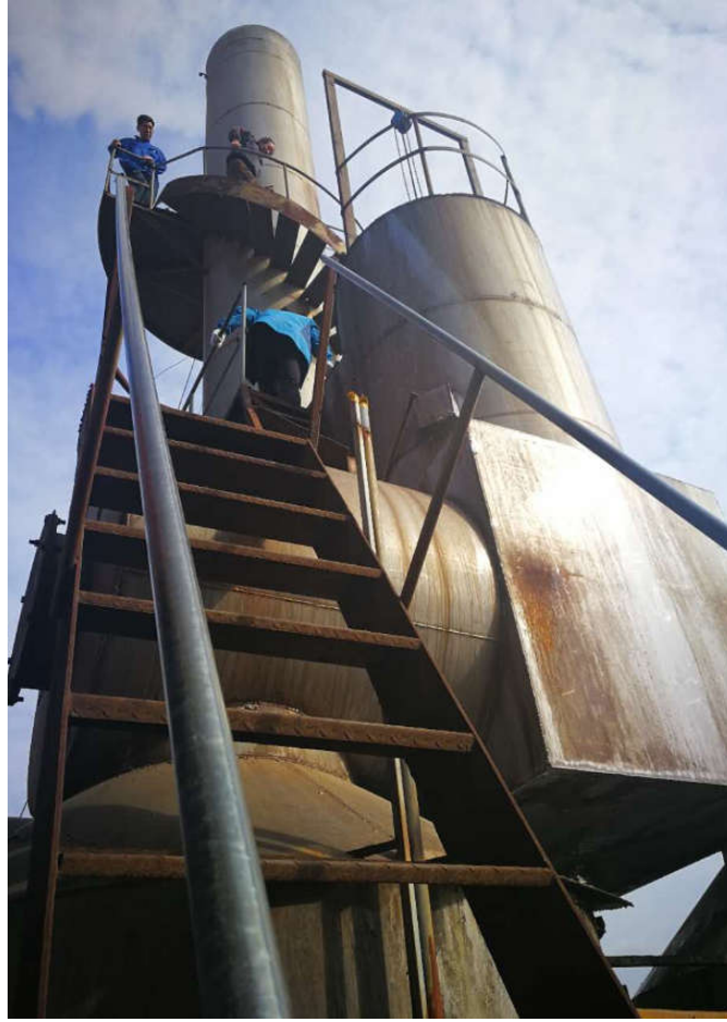
图 14—9 烟气排放监测点位监测设施护栏不规范不安全示例
