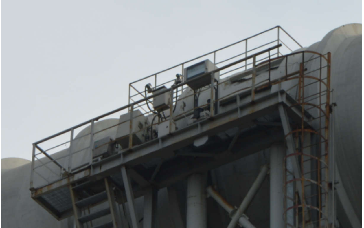
图 14—3 烟气排放监测点位监测设施监测平台过窄，不能满足规范要求的示例
