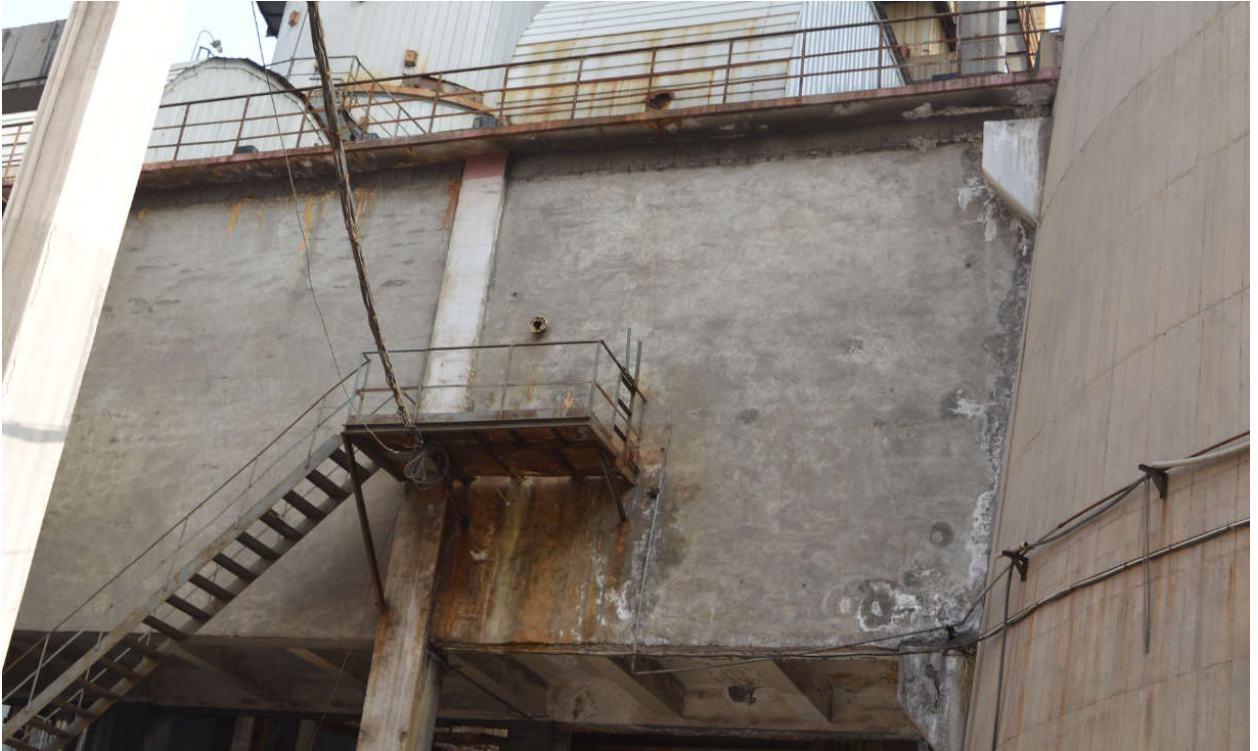
图 14—5 烟气排放监测点位监测设施监测孔设置不合格不规范的示例
