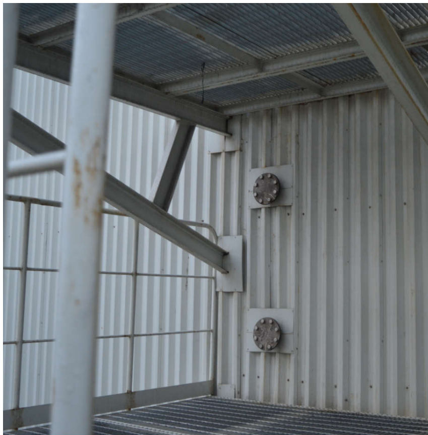
图 14—12 烟气排放监测点位监测设施监测平台、护栏、踢脚板和监测孔规范的示例
