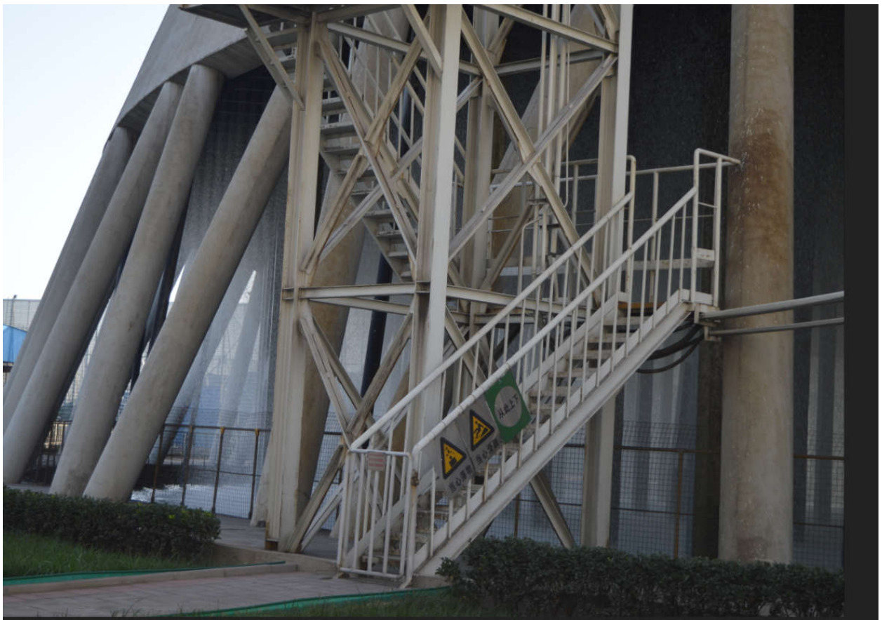
图 14—8 烟气排放监测点位监测设施步行梯和护栏规范示例
