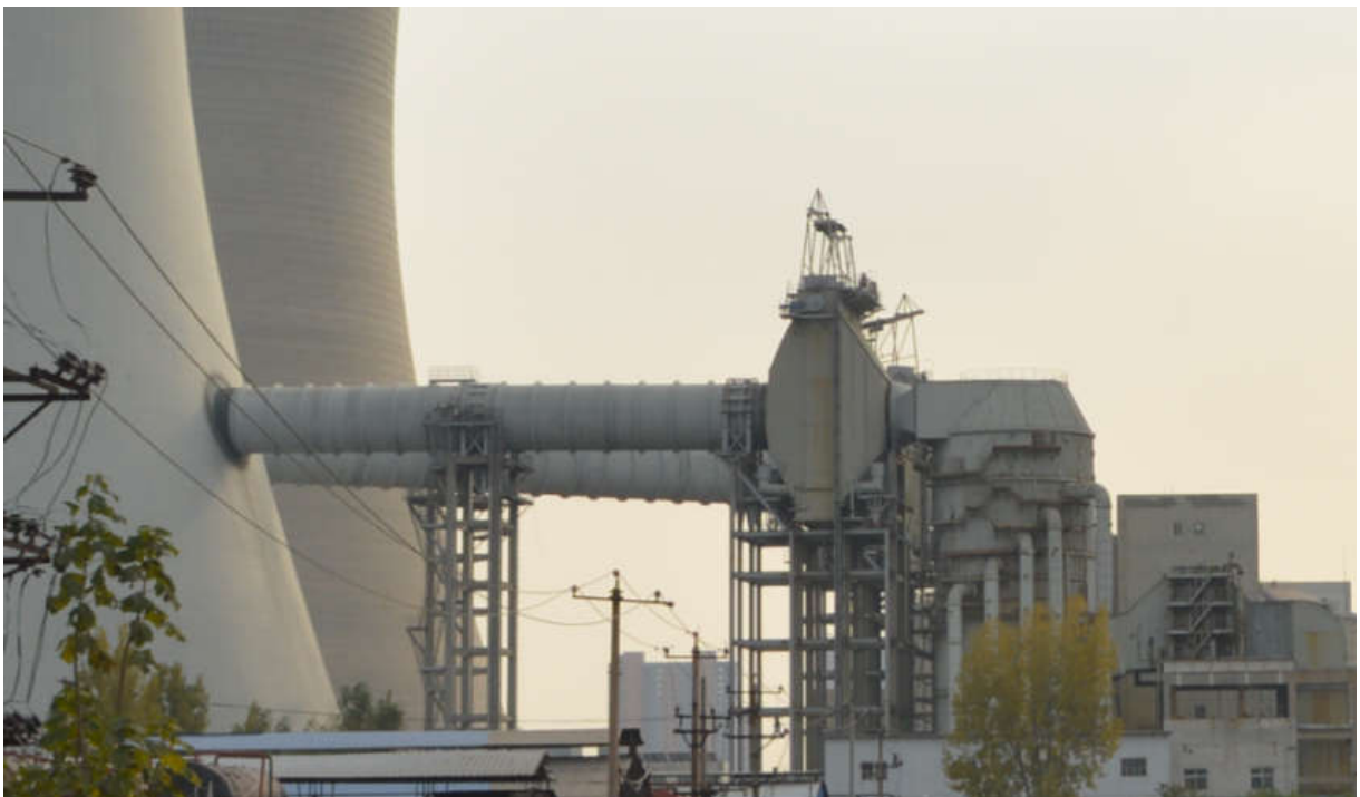
图 14—2 烟气排放监测点位监测设施排气监测管筒长度满足前“六”后“三”的示例
