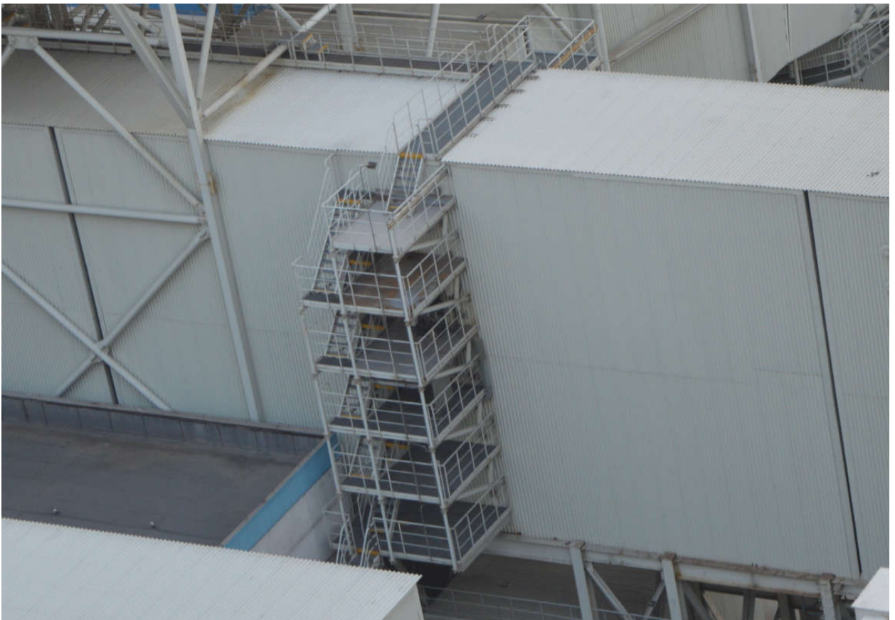
图 14—4 烟气排放监测点位监测设施监测平台层数、宽度、长度均符合规范要求的示例
