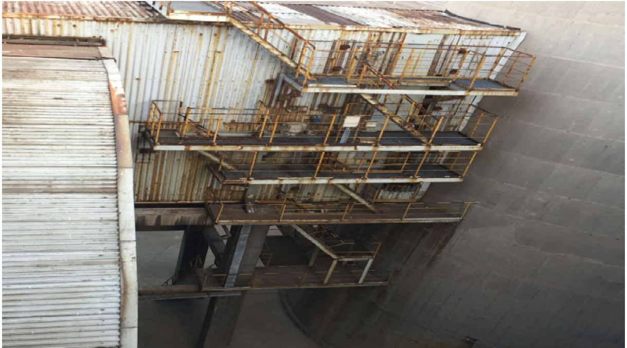
图 14—1 烟气排放监测点位监测设施排气监测管筒长度不满足前“六”后“三”的示例
