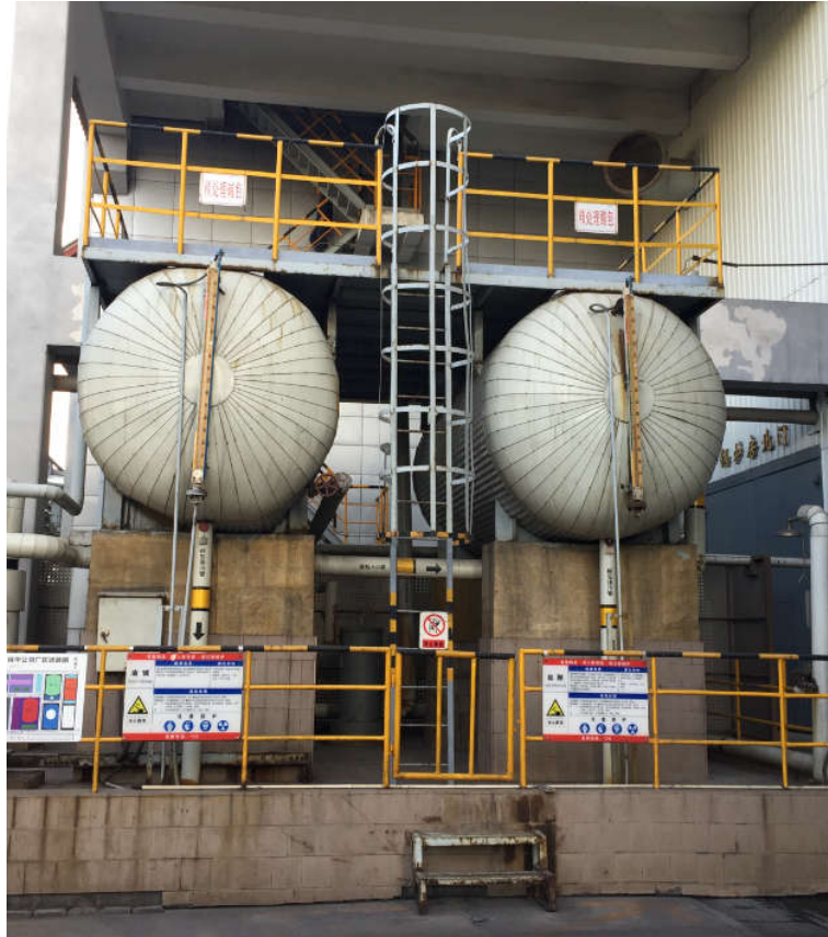
图 14—11 烟气排放监测点位监测设施护笼规范的示例
