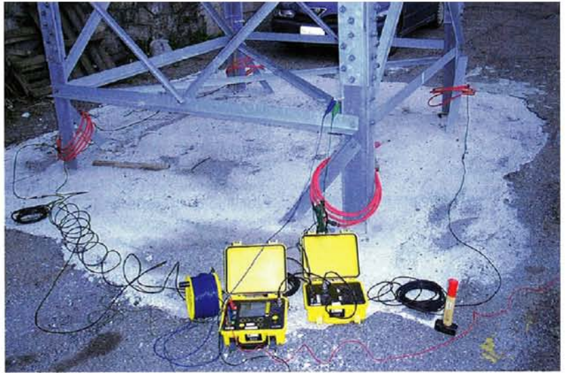
Abb. 2. Selektive Erdungsmessung eines Mastes mittels Rogowski-Spule
