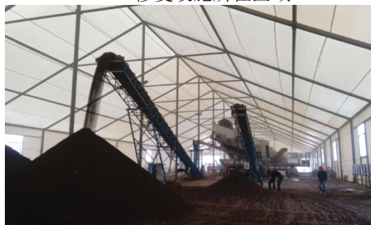
修复设施内部
