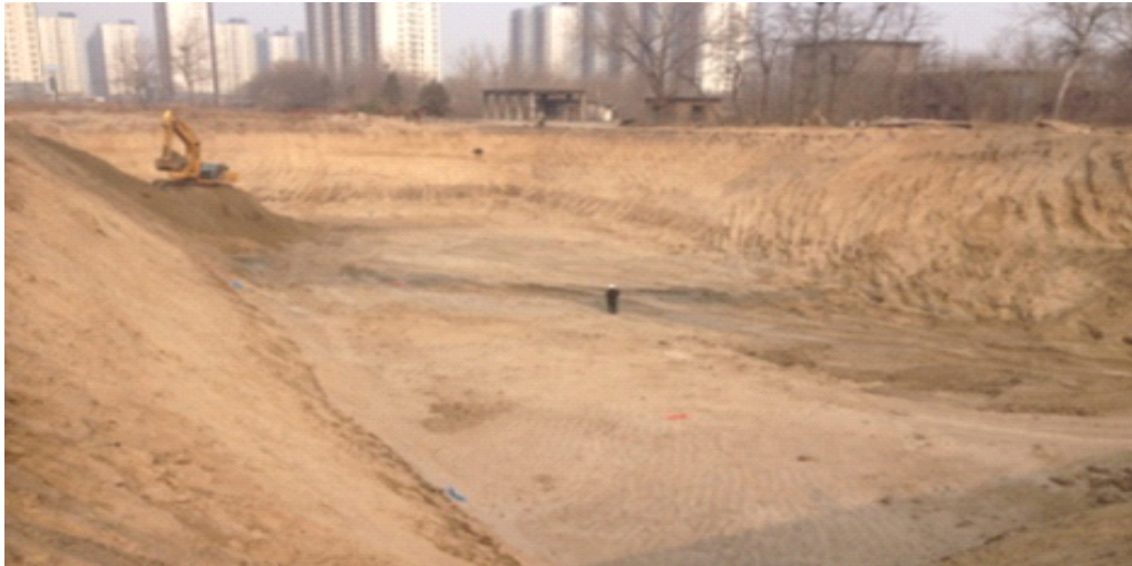
图 7 10 异位清理遗留基坑照片
