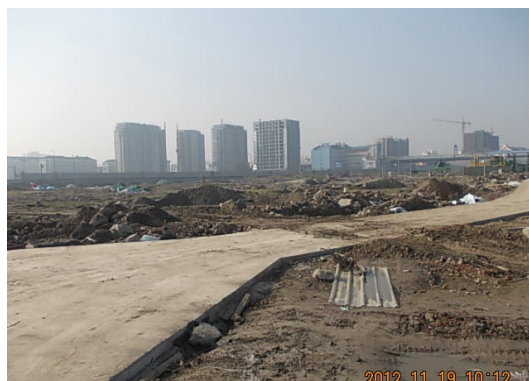
修复场地临时道路
