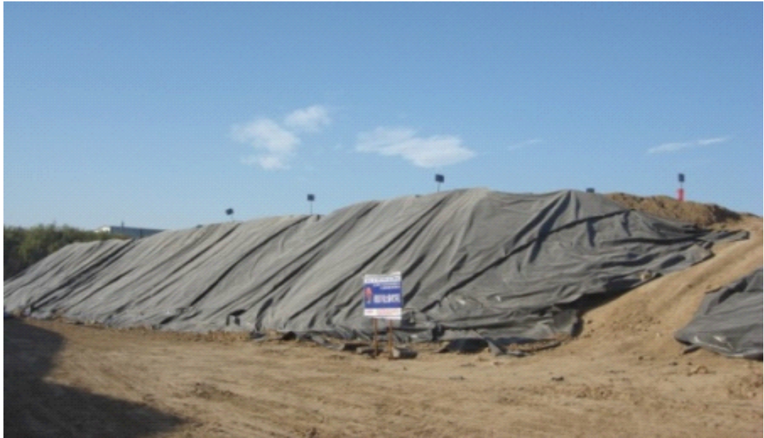
图 7 14 异位修复后土壤堆体照片
