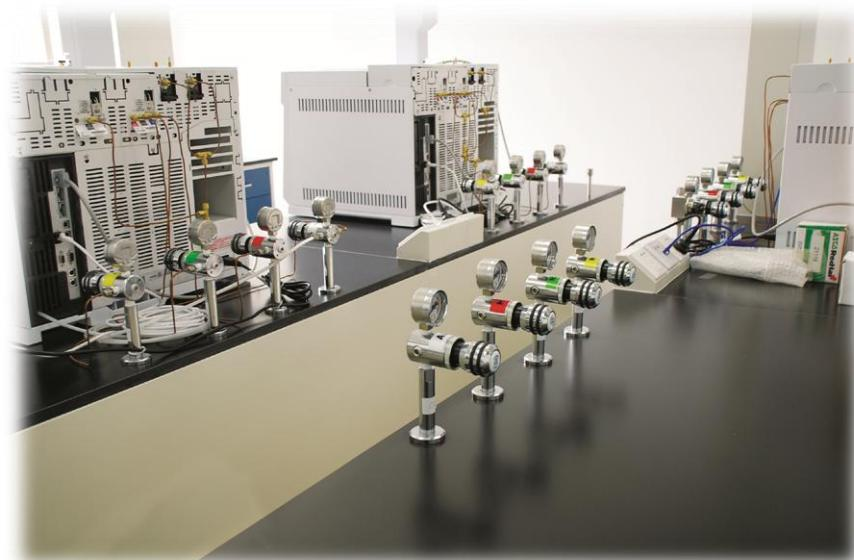
高纯气体中央供气系统是专为高精度分析测试设备所用高纯工作气体的传输而设计，系统需要为分析设备提供压力、流量稳定且经过长距离传输后纯度不变的高纯气体以满足各种高精度分析设备的使用要求，系统同时还应该满足安全性的要求，并方便客户的日常使用及管理，随着实验室越来越多的使用纯净气体来进行分析实验，气体管道的清洁性和安全性就日益成为实验研究人员所关注的问题，特别是对于一些易燃易爆的如氧气，氢气，乙炔等危险性气体，一套高质量的安全的供气系统更是至关重要的。
