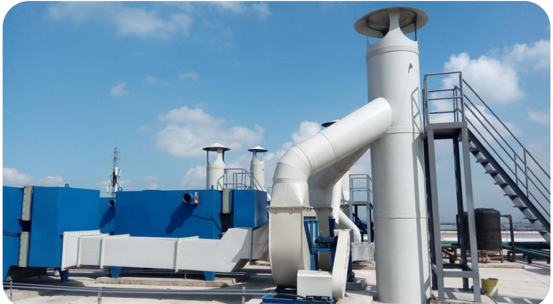
PP 离心机通风机系列,是目前最理想的耐腐通风设备, 产品具有强度高、耐腐性强、运转平稳、噪声低等优良性能, 经过不断改进、精心设计, 产品日益完善已广泛替代其它耐腐材料的风机。
