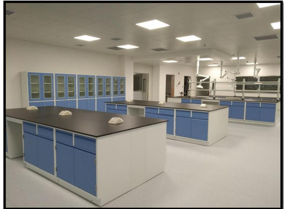
全钢实验台具备承重性能好、使用寿命长和性价比优良等优点，整体采用电脑辅助设计、数控制造，为单元体结构，制造精确度高，可以随意搭配组装方便，适应性强，满足您实验室空间需求，全钢实验台整体以 1.2mm 厚国产/进口优质一级冷轧/镀锌钢板为基材，全自动压模成型；表面经过磷化、酸洗，再通过环氧树脂（EPOXY）粉末烤漆处理，无突出漆块，光洁亮丽，抗强酸强碱性能突出。
