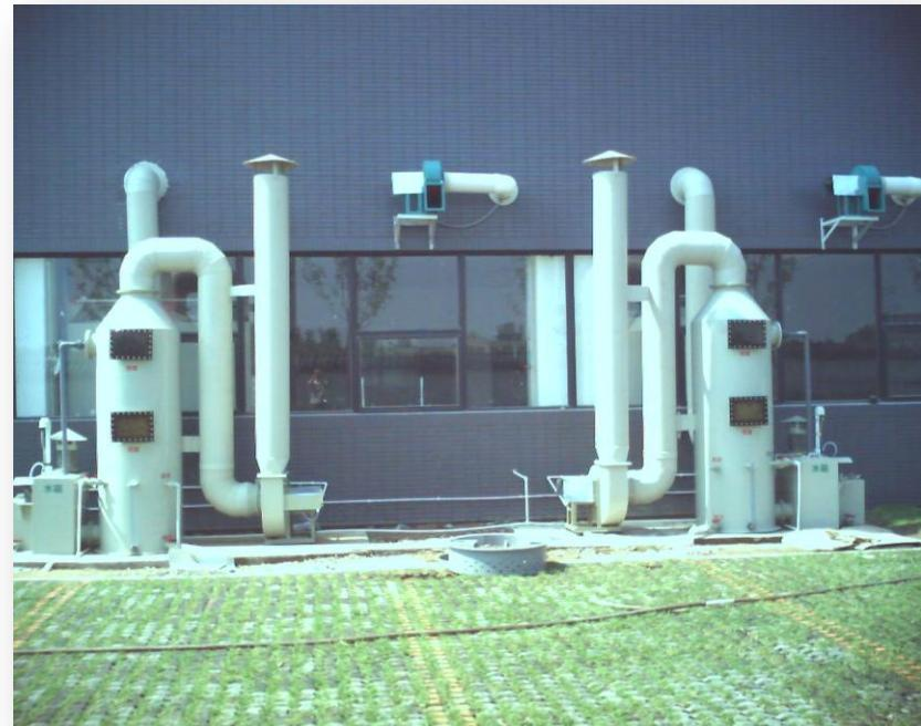
实验室废气处理装置 PP、PVC 为主要材料生产的塔设备均为填料喷淋塔。填料采用 PP 材质的鲍尔环或空心球。根据气体吸收过程中气液两相在表面上进行传质反应以及传递速率和比表面积成正比的原理，因此采用填料来增大两相接触的比表面积，使两相充分接触，从而达到吸收或净化废气的目的。
