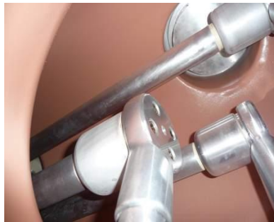
GIS 设备内部结构与 X 射线成像图
