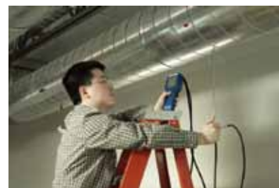
管道截面法测风量: 毕托管
