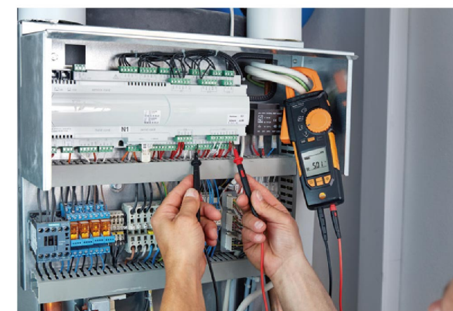
测量开关柜电压
