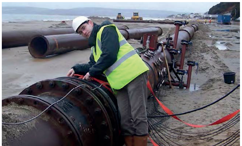
安装在泥浆管中的 DENS-ITOMETER 传感器
