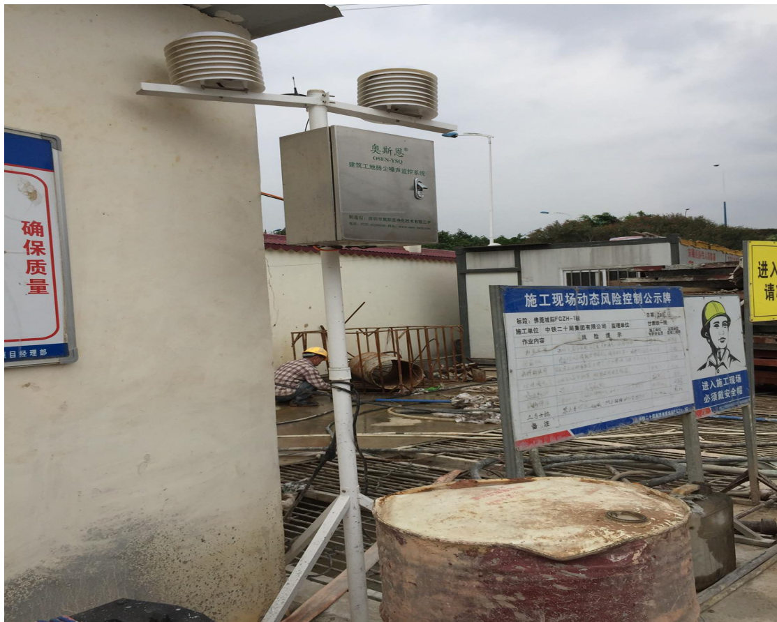
中铁十二局佛莞城际 FGZH-1 标项目工地
