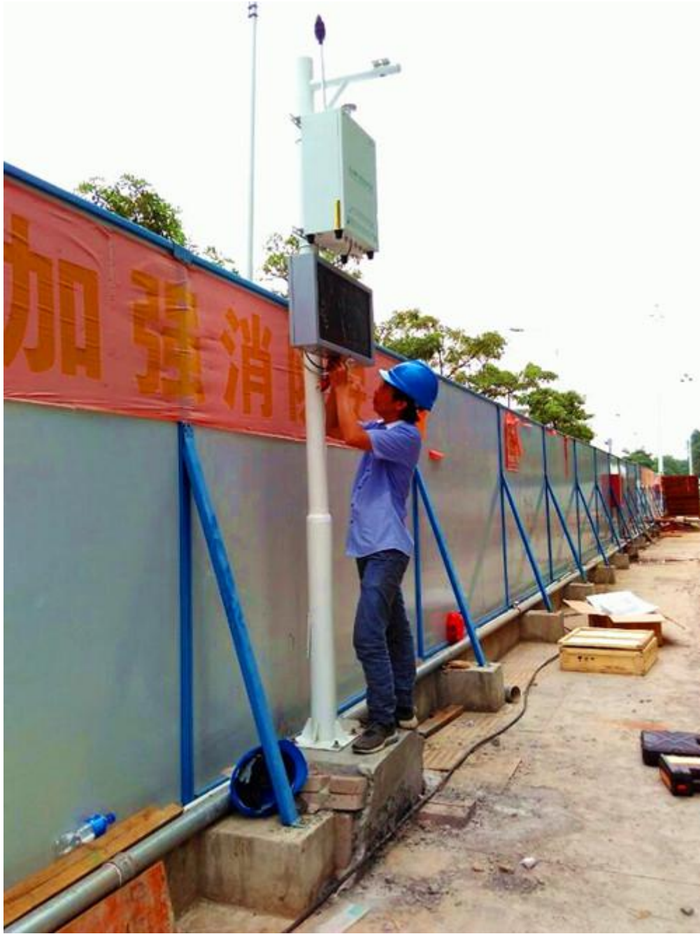
深圳海纳百川总部大厦建设工地
