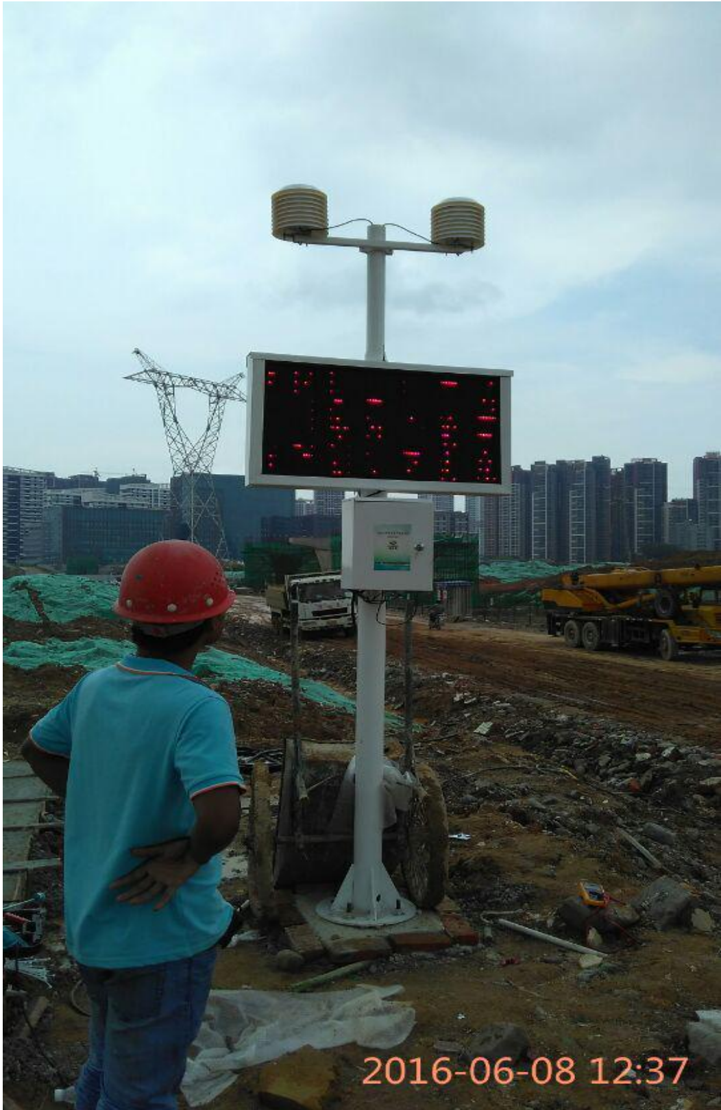
中铁二十三局深圳市光明新区同观路工地
