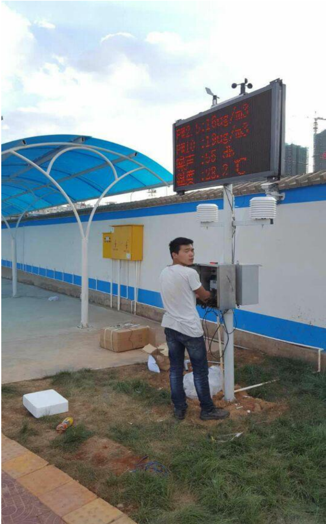
昆明联想科技城工地
