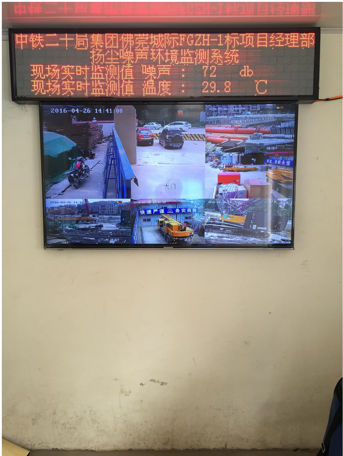
佛莞城际 FGZH-1 标项目工地
