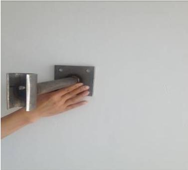
第一步：把固定支架用膨胀螺丝固定在墙上。
