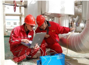
技术人员正在用测汞仪对天然气进行汞含量检测
