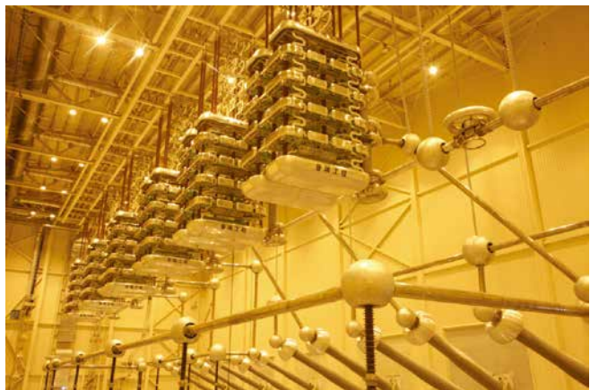
±800kV 特高压直流换流阀
