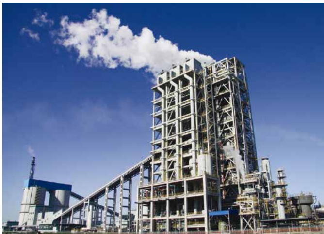
2000吨/天干煤粉加压气化装置
