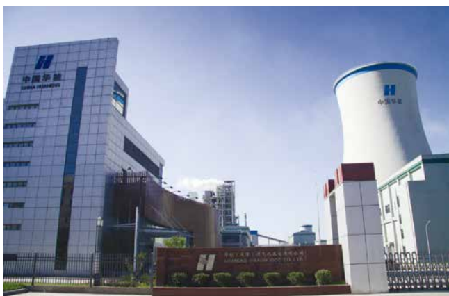
250MW 级 IGCC 发电装置
