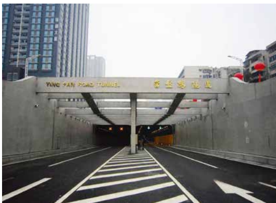
长沙营盘路隧道应用工程
