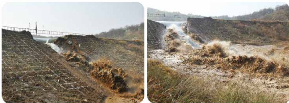
溃坝试验和模拟（试验坝：最大坝高 9.7m；坝体材料 C 值范围 6.5~39.5kPa）
