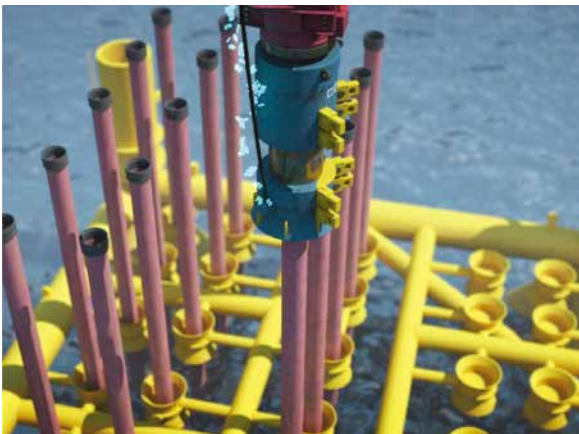
浅水海域隔水导管打桩施工
