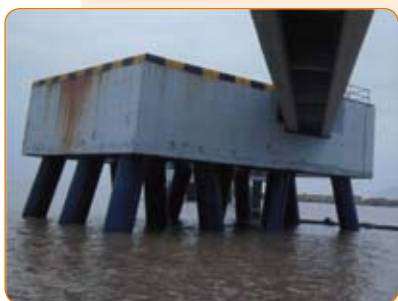
浙江舟山中化兴中码头钢桩防腐工程
