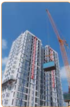
镇江港南路公租房施工现场
