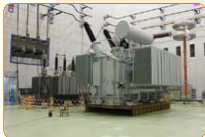
节能型卷铁芯牵引变压器
