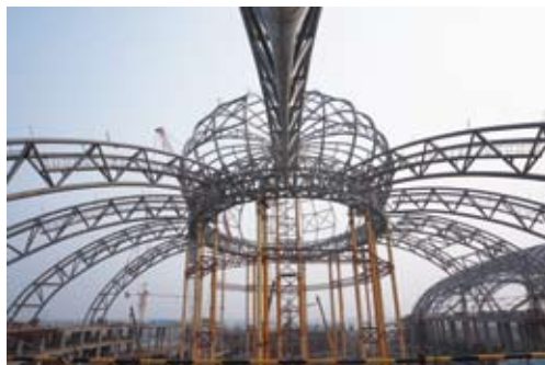
E馆（山馆）径向桁架吊装
