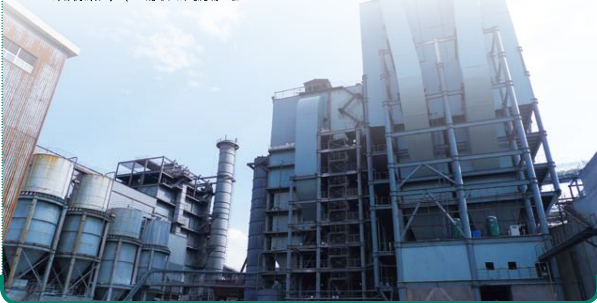
西昌钒钢公司1#、2#烧结机烟气脱硫工程
